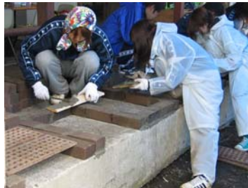
作業ワークのかまど作り セメントなんてはじめてだよ…といいながらも立派なできあがりに満足d(^o^)b
